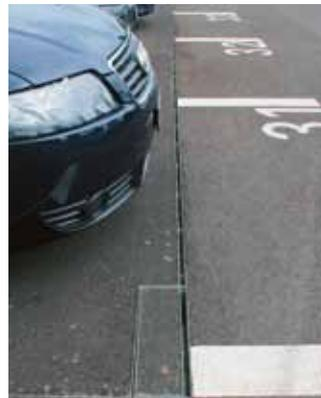
BIRCO PLUS® Schlitzaufsatz aus Stahl feuerverzinkt, asymmetrisch mit Spülkastenaufsatz
