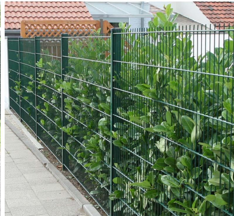
Der Zaunpfosten Allround kann sowohl bei schweren und leichten Doppelstabgittermatten, als auch bei U-Profilgittern eingesetzt werden. Für die Montage verschiedener Zauntypen sind jeweils spezielle Keile vorhanden, die mit einer Spe-
