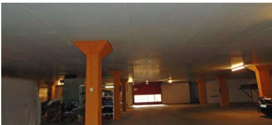
Eine bauliche Ertüchtigung von Bestandsbauteilen wie Decken und Wänden aus Stahl- bzw. Spannbeton wird immer dann notwendig, wenn eine höhere Feuerwiderstandsdauer erforderlich wird. Dies ist häufig der Fall wenn es beispielsweise zu einer Umnutzung des Gebäudes kommt. Denn häufig weisen ältere Bauteile wie zum Beispiel Decken nicht die notwendige Betonüberdeckung von min. 35 mm gemäss DIN 4102 auf.
