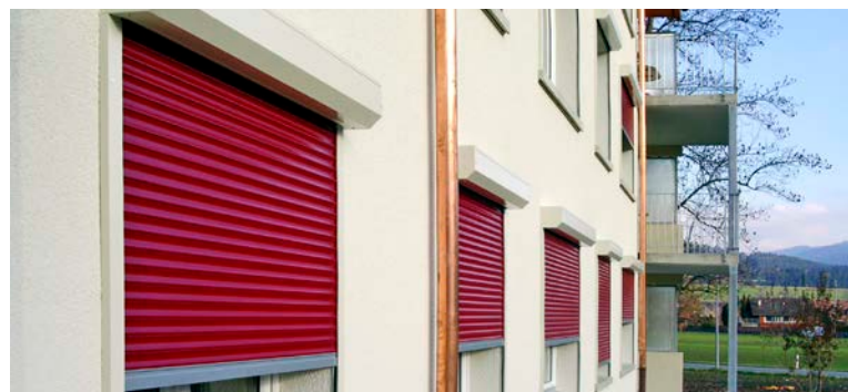
Rollladen ersetzen Jalousien und ermöglichen automatische Steuerung
