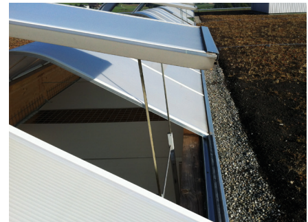
Öffnungsvorrichtung mit Zahnstangenantrieb
