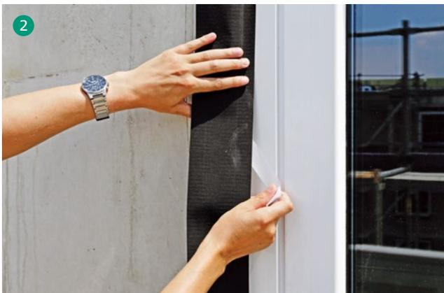
Enlever le liner d'un côté, positionner la bande et la coller sur le cadre tout en continuant à enlever le liner, bien presser. Déployer ensuite la bande, enlever l'autre partie du liner, repositionner la bande et enlever le liner en appuyant sur la feuille en continu.
