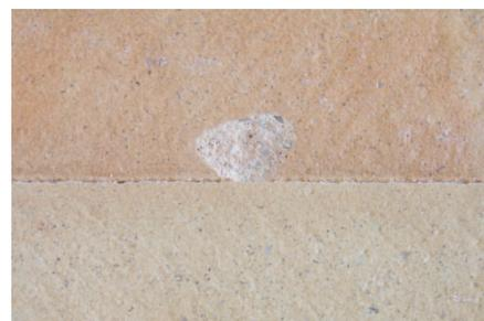
Abplatzung, ausgelöst durch nachträgliche Spannungen.
