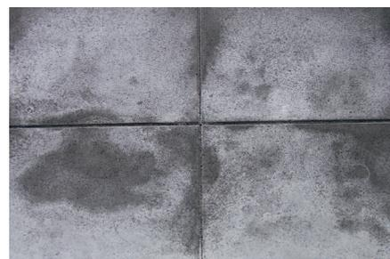
Ausblühungen, ausgelöst durch Feuchtigkeitsstau in der Unterlage und Entwässerung durch die Platten.
