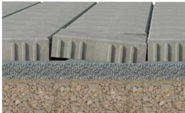
Figure 6: Forte déformation due aux efforts de cisaillement en présence de pavés minces
