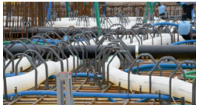
Das Schubverstärkungssystem FIROLA® wurde mit sehr guten Ergebnissen auf der Baustelle getestet. Resonanz der Bauunternehmung und des Planers war aufgrund der hohen Flexibilität, Einfachheit und Geschwindigkeit der Montage sehr positiv.
