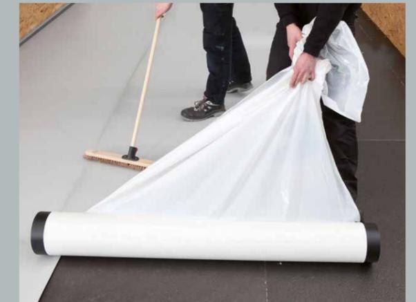
Retirer le film de protection parallèlement au rouleau, établir une pression sur le rouleau avec un balai plat ou avec un rouleau.
