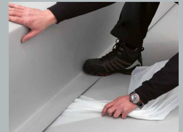
Raccorder l'acrotère à l'aide du lé SK de 0,75 m, le former à l'angle, retirer le film de protection parallèlement à l'angle et établir une pression sur la surface.
