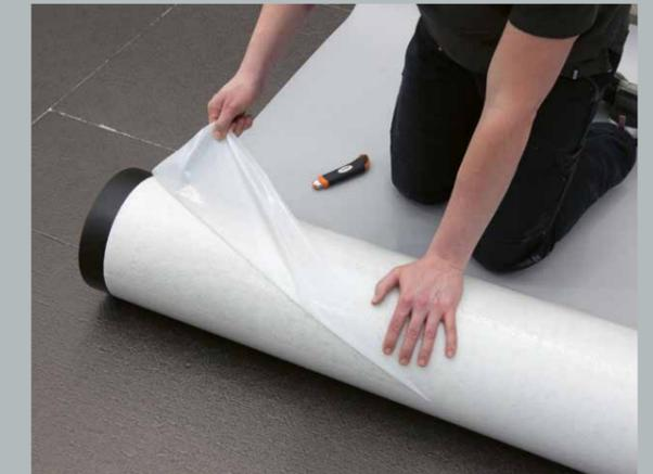
Application du lé de toiture jusqu'à la moitié du rouleau, couper le film de protection.
