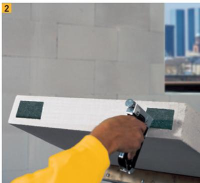
Rubberblock zum Entkoppeln von Bauteilen
