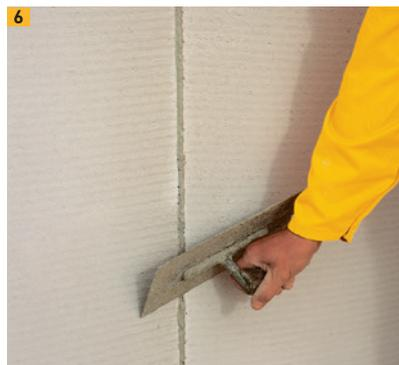
Stoßfugen werden vermörtelt und die Mörtelreste abgestreift
