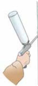
14. Wenn alle Elemente aufgerichtet sind, werden alle Anschlussfugen an der Decke und flankierenden Wänden mit Montageschaum geschlossen.
