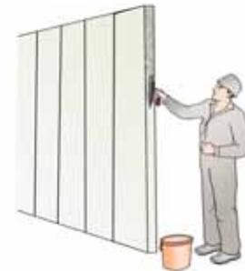
12. Jede Stossfuge wird mit Ytong fix P vermörtelt, so dass nach dem Zusammendrücken der Elemente eine ca. 1-3 mm dicke Fuge entsteht. Da die Oberfläche hierbei besonders wichtig ist, sollten die Stoßfugen vollflächig vermörtelt sein und ein Versatz verhindert werden.
